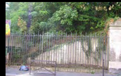
Rue Desnouettes: grille existante et conservée
