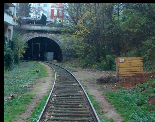
Talus rue Olivier de Serres et tunnel
